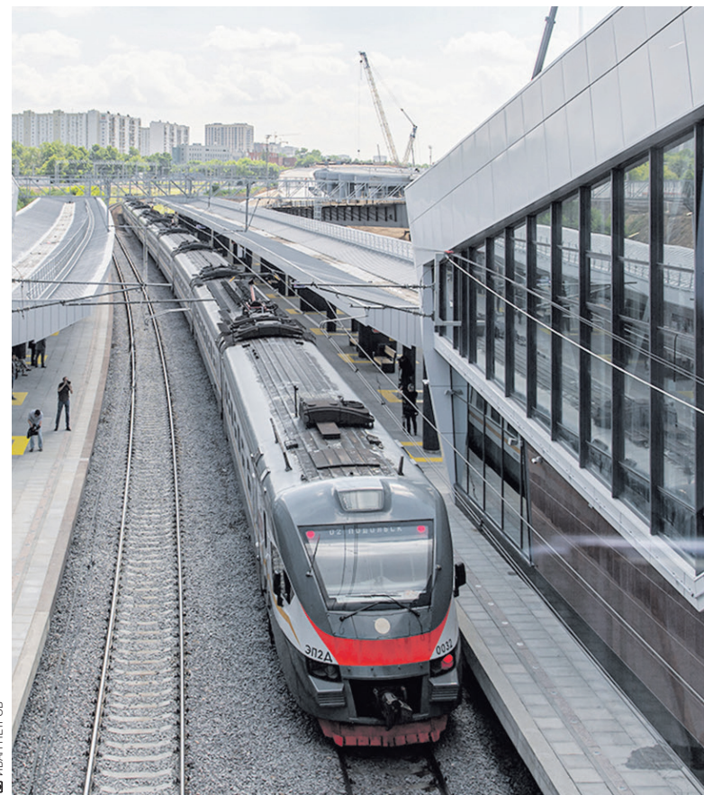
Новая станция «Печатники» второго маршрута Московских центральных диаметров (МЦД-2)
